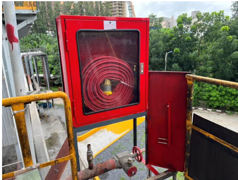
แก้ไขตู้สายฉีดและหัวฉีดน้ำ CFB ชำรุด พร้อมติดตั้งประแจ F
